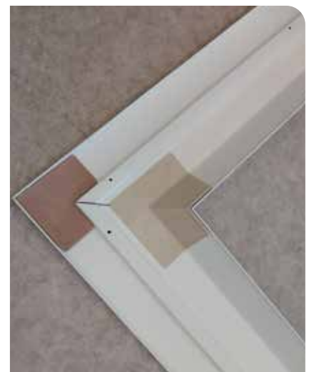
상부가이드 1, 2 시공 후 모습
